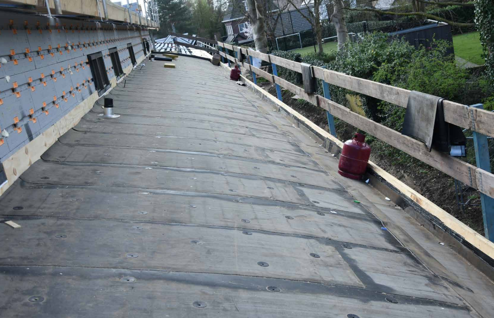
^ Op de isolatie is de bitumineuze onderlaag Polybond Plana 460P14 aangebracht, mechanisch bevestigd op de stalen onderconstructie. (Beeld: Polyglass)
