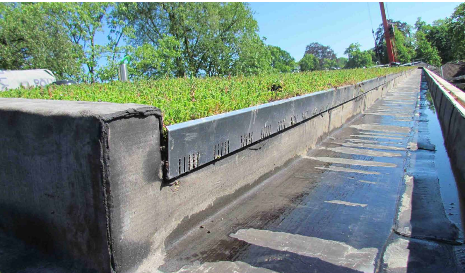
^ Aansluiting dakgoot met waterdoorlatend L-profiel.
