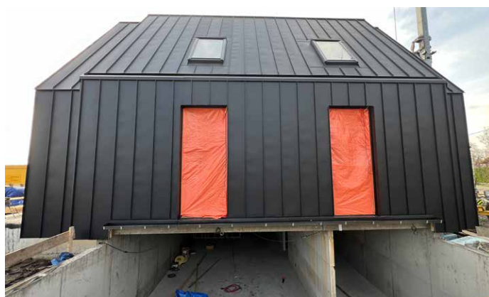
^ Onderaan de gevel, boven de patio van de kelderverdieping komt een aluminium dakgoot.
