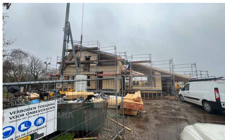
^ Veilig werken dankzij een vaste steiger rond het gebouw
