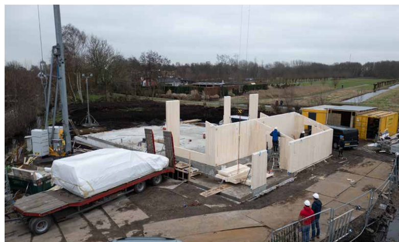
^ Bovenop de betonnen kelder verdieping is het CLT bouwdeel, aangeleverd als bouw pakket, in korte tijd de basis voor de villa in Reeuwijk.
