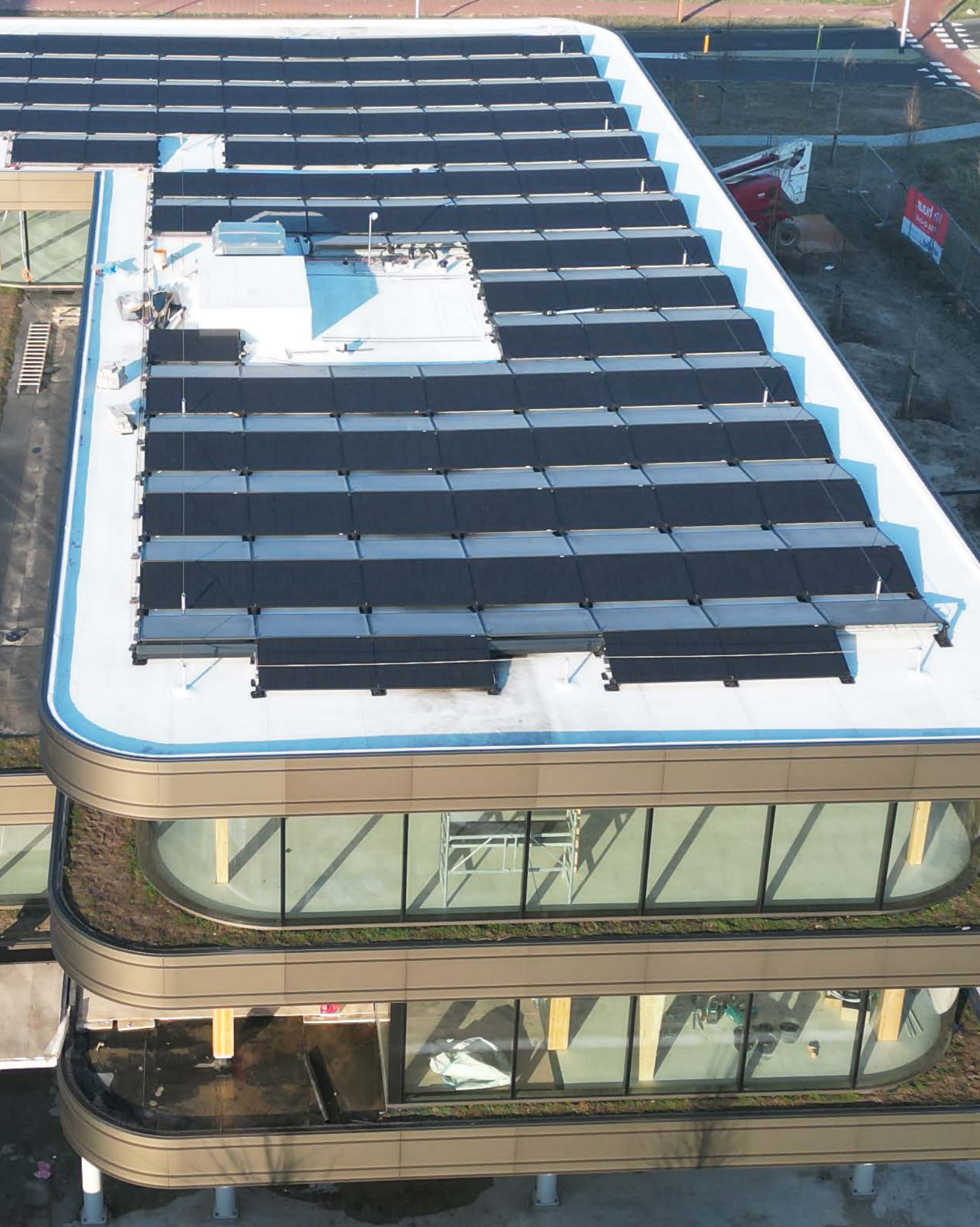
Ruim 200 PV-panelen op het dak en een kleine liftdoos. De installaties zijn in alle het gebouw weggewerkt. (Foto: Van Vliet Bedrijfsmakelaars)
