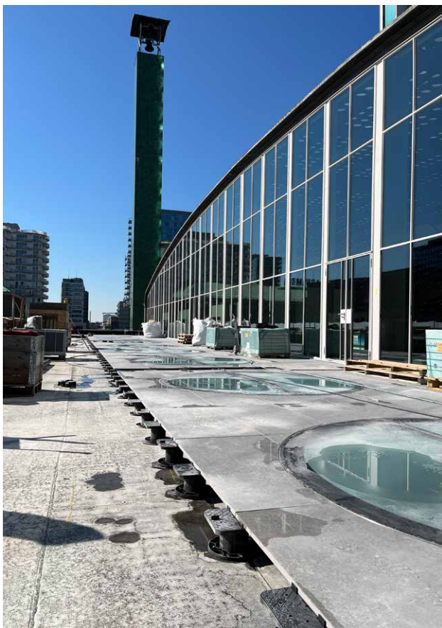
^ Een solide dakpakket om een probleemloos gebruiksdak mogelijk te maken. (Foto: Zoontjens)
