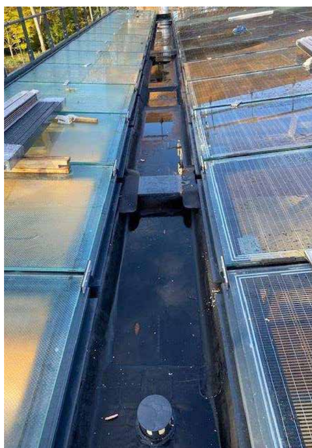
^ Afgewerkte goot. (Foto: Huijbers)
