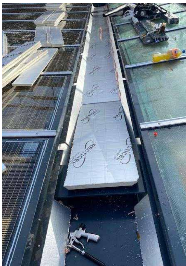
^ De stalen goten liggen niet op afschot, daarvoor zorgt PIR-afschot. (Foto: Huijbers)
