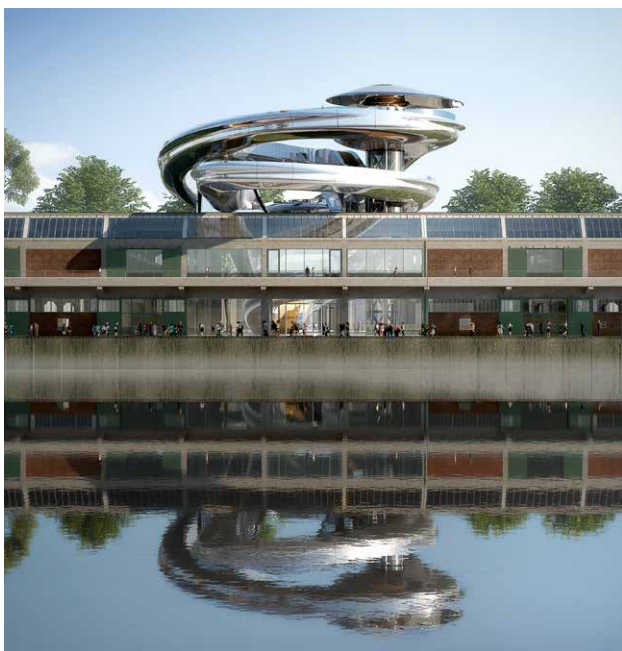
^ De Tornado rijst op uit de loods. (MAD)
