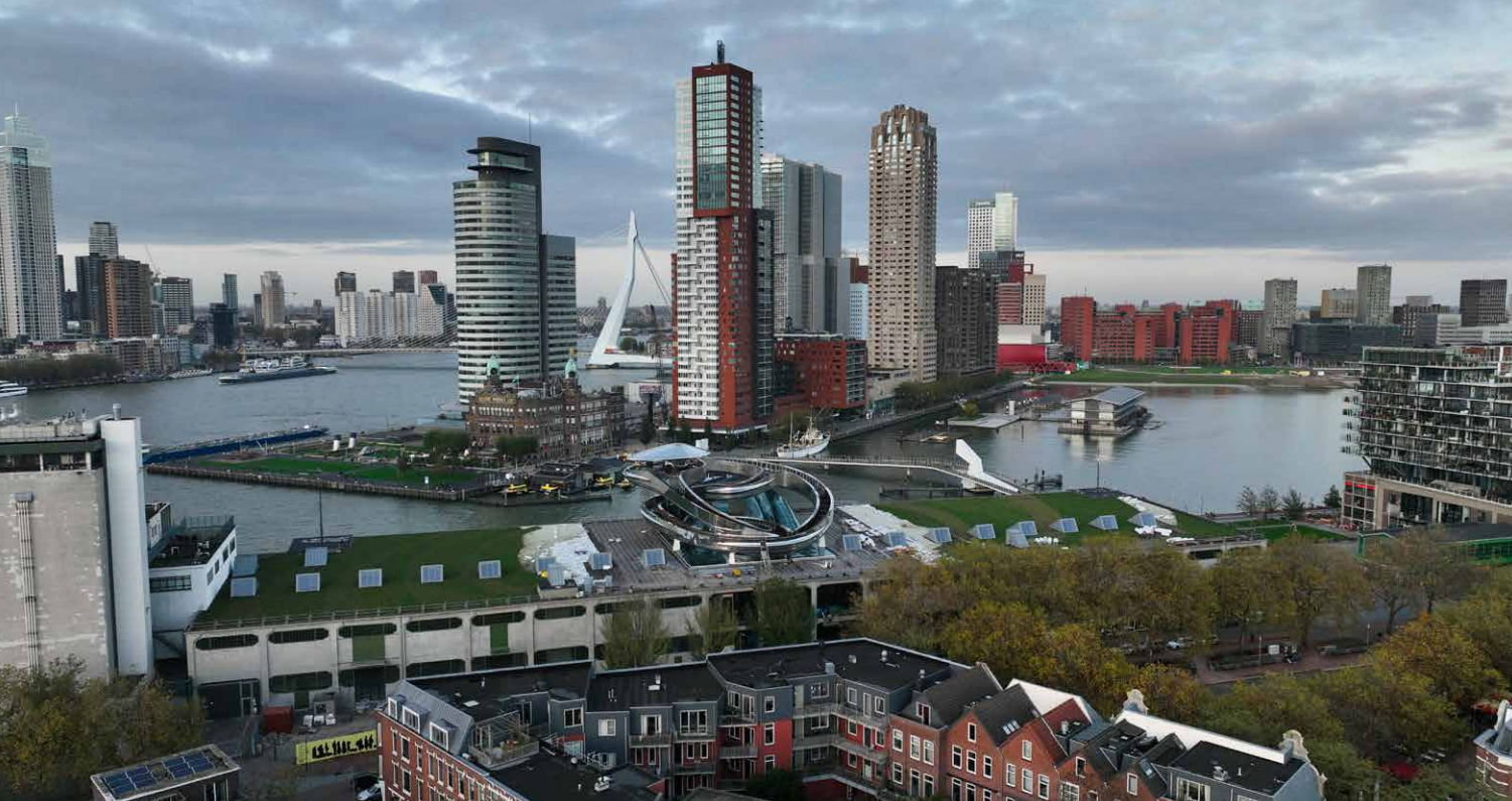
^ Luchtopname van herfst 2024. Het sedumdak is deels klaar, de middenzone wacht nog op isolatie, dakbedekking en groen. Geheel rechts Fenix I, ooit ook onderdeel van de San Fransisco Loods. (Foto: Fenix)
