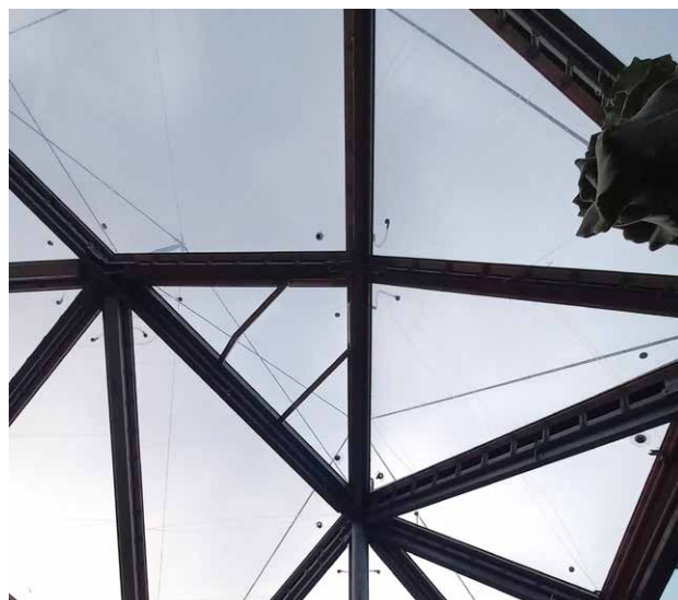
^ Via een luchtleidingwerk met blowerkast worden de kussens met droge lucht op een constante lichte overdruk gehouden. (Foto: Maarten Holdrinet, Buitink Technology)
