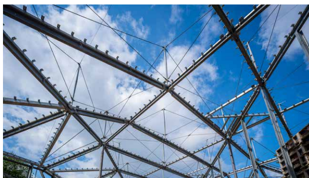
^ Vernieuwde staalconstructie: resultaat van scannen, Bimmen, rekenen en bouwen. (Foto: AKOR)
