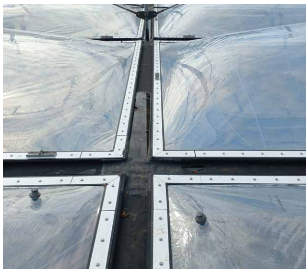
^ De ETFE-kussens zijn stuk voor stuk ingeklemd tussen twee aluminium lamellen en op de staalconstructie geschroefd. (Foto: Maarten Holdrinet, Buitink Technology)
