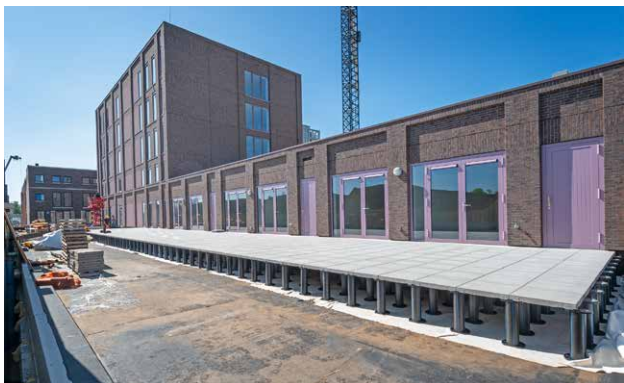
^ Terrassen zijn bijna een halve meter opgetild, wat ruimte geeft voor de leeflaag in de groene vakken. (Foto: Zoontjens)
