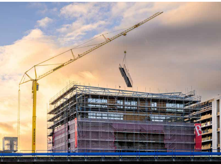
^ Het inhijzen van een trap voor het nieuwe fotomuseum
