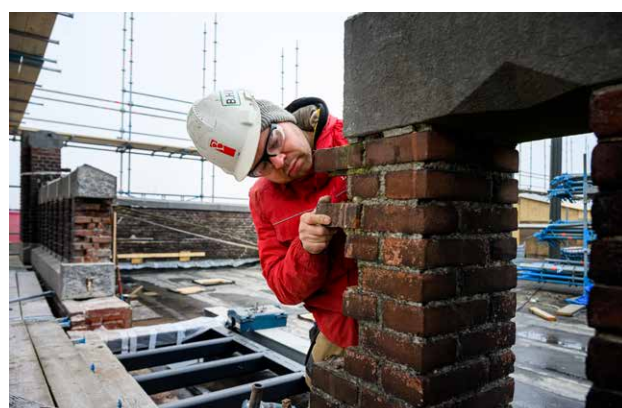
^ Herstel van het voegwerk
