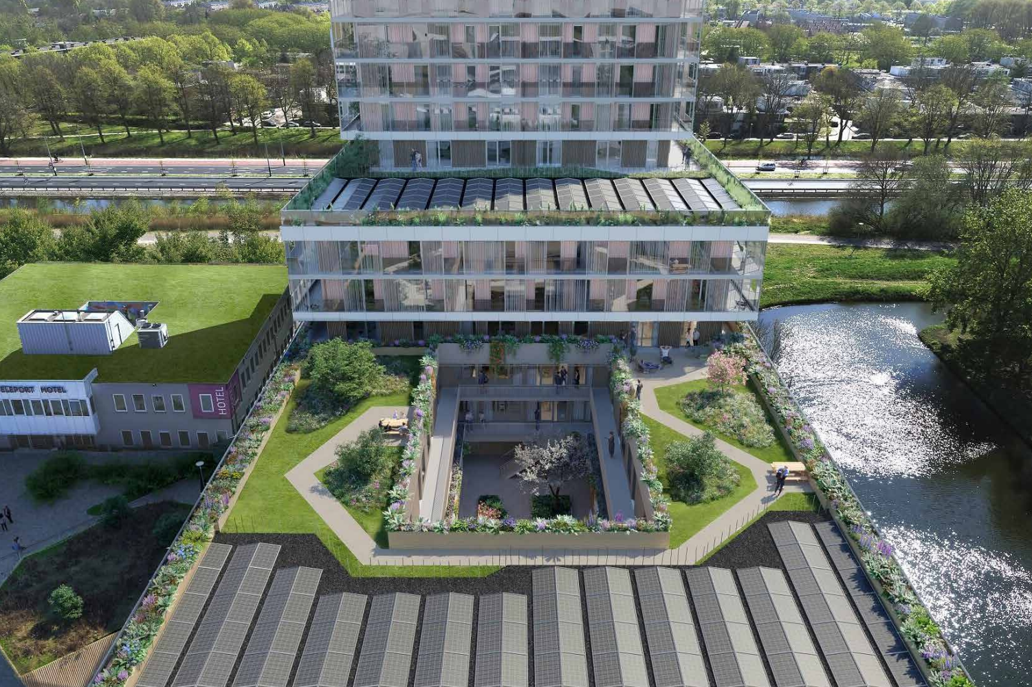
^ Daktuinen op de vijfde en achtste verdieping en de patio in één oogopslag. (Impressies: Orange Architects/Vero Digital)
