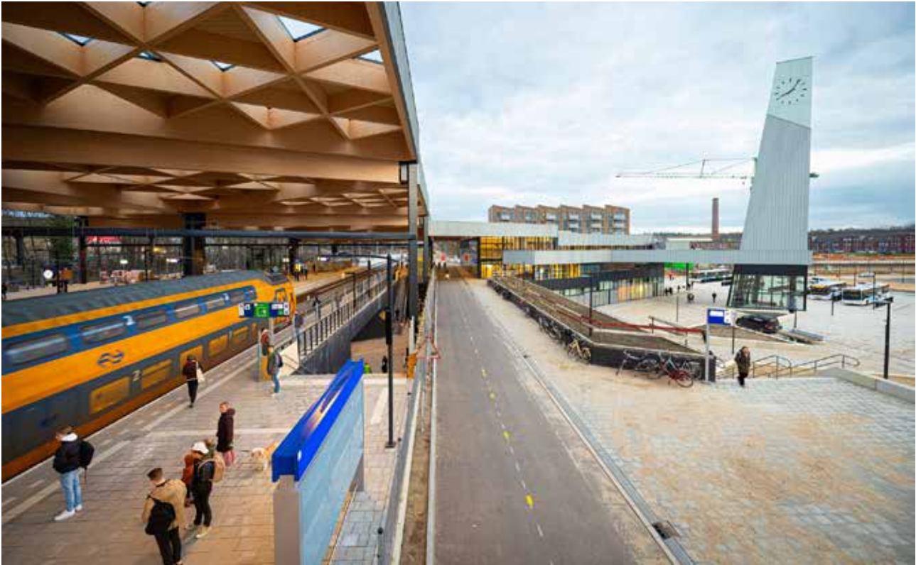
^ Reizigers beschut onder een 'bladerdek'. Rechts een ander nieuw beeldelement: de met zink beklede toren van het station.
