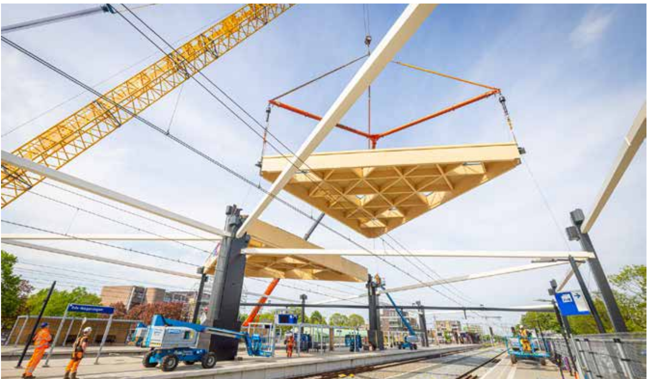
^ Het plaatsen van de eerste van de 24 dakelementen
