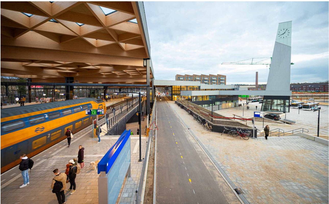
^ Reizigers beschut onder een 'bladerdek'. Rechts een ander nieuw beeldelement: de met zink beklede toren van het station.
